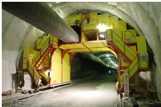
シート張り台車を利用した消音機構
