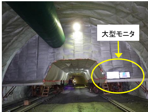
写真1 トンネル内の大型モニタ設置状況
