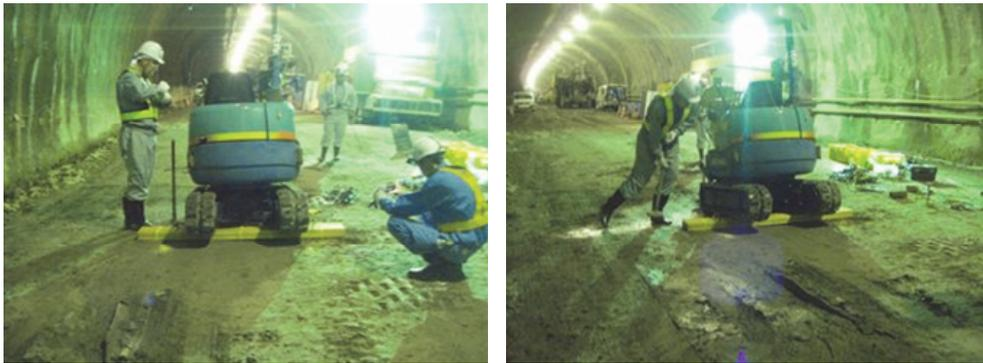
(a)油圧インパクトにて板を固定 (b)大ハンマによる打撃
